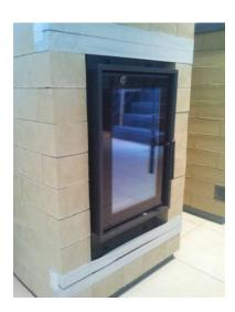
B) Passer le produit de finition sur les briques avec un rouleau à poils long.
